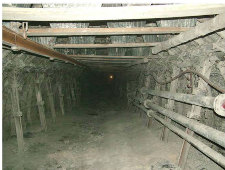
Rys. 13. Widok chodnika I/VI utrzymywanego za ścianą
