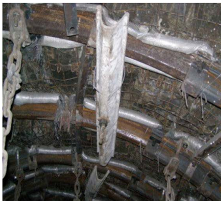
Rys. 6. Widok przykotwionych odrzwi wraz z wykładką mechaniczną (fot. A. Ruchel)
