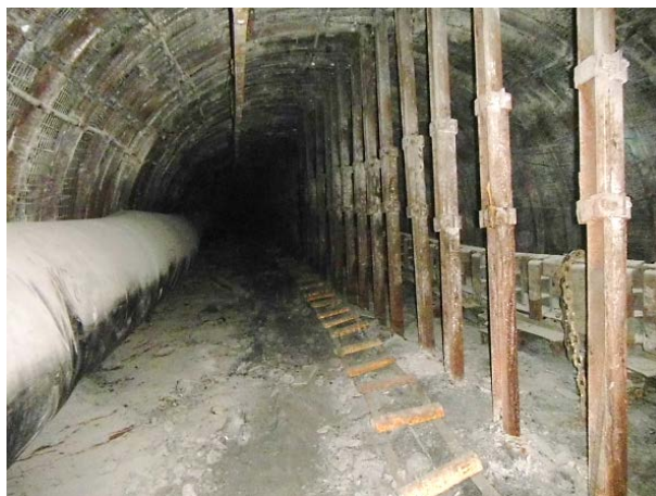
Rys. 5. Widok rozcinki ścianowej rozruchowej w obudowie ŁPKO/V32/8/8 wzmocnionej stojakami stalowymi w rozstawie odrzwi obudowy co 0,75 m w rejonie wpływu krawędzi eksploatacyjnych (Bobek i in. 2013)
