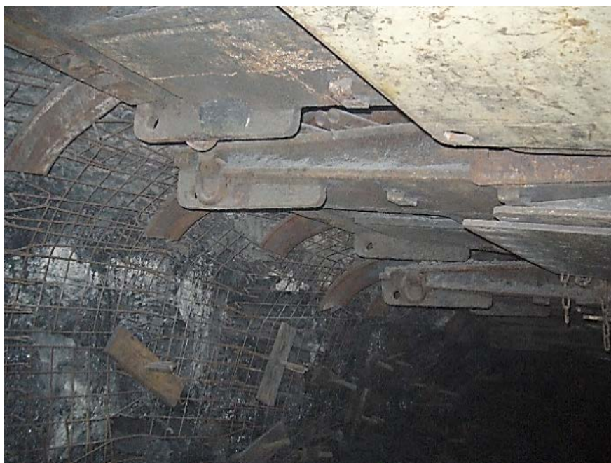
Rys. 25. Widok uciętych łuków stropnicowych obudowy ŁPrP dla umożliwienia przejazdu kombajnu ścianowego
