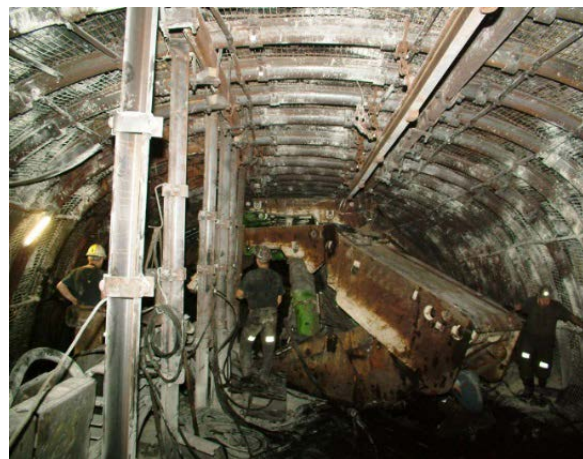
Rys. 11. Zabudowa sekcji obudowy zmechanizowanej FRS19/45-2 × 3056 w rozcince ścianowej rozruchowej w obudowie ŁP3R-V32/4/8,2 × 3,8
