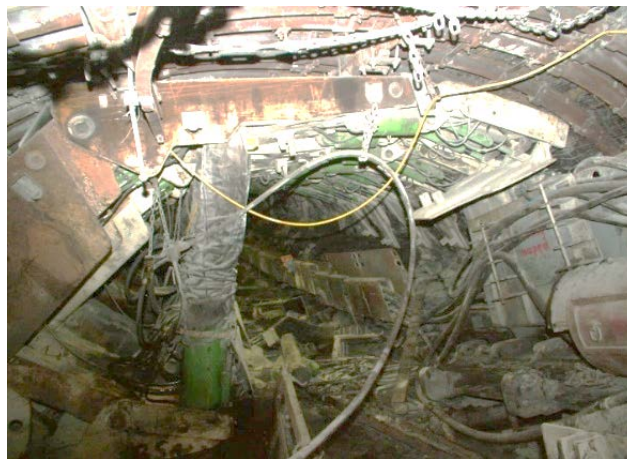
Rys. 10. Zabudowana sekcja obudowy zmechanizowanej FRS19/45-2 × 3056 w rozcince ścianowej rozruchowej w obudowie ŁP3R-V32/4/8,2 × 3,8
