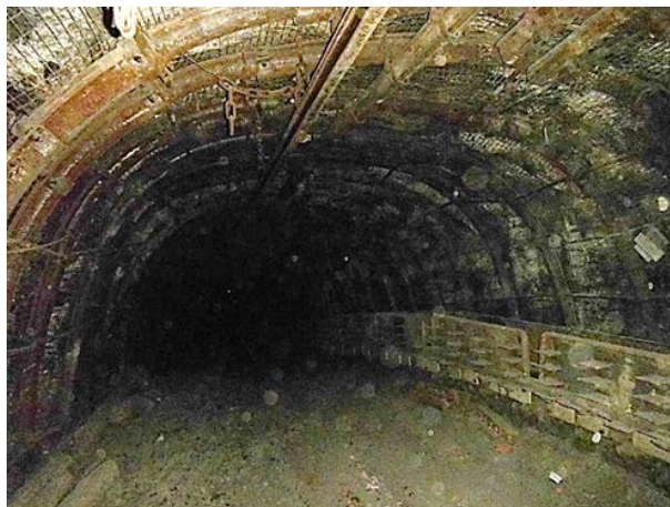
Rys. 18. Widok rozcinki ścianowej 41 w pokładzie 357+358 w obudowie ŁPSpA-V32/4/5,8 × 3,5 w rozstawie odrzwi co 1,25 m
