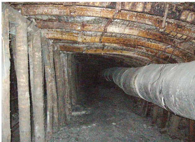
Rys. 3. Widok rozcinki ścianowej rozruchowej w obudowie ŁPrP podbudowanej stojakami drewnianymi w rozstawie odrzwi co 0,75 m w rejonie wpływu krawędzi eksploatacyjnych
