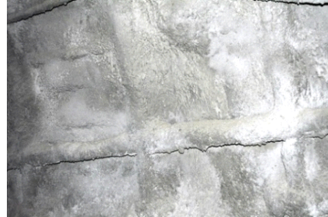
Rys. 19. Wzmocnienie betonem natryskowym z założonymi gnomatami
