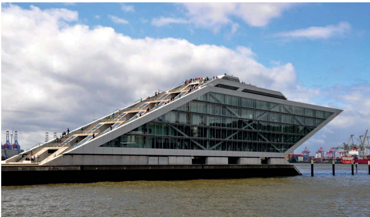
Il. 2. Dockland (2006 r.) – autorstwa niemieckiego biura BRT Architekten , zlokalizowany w dzielnicy Altona-Altstad ze względu na lokalizację oraz formę architektoniczną, której motywem był dziób statku, jest jednym z najbardziej rozpoznawalnych hamburskich budynków biurowych (fot. Katarzyna Zawada-Pęgiel, 2014)
