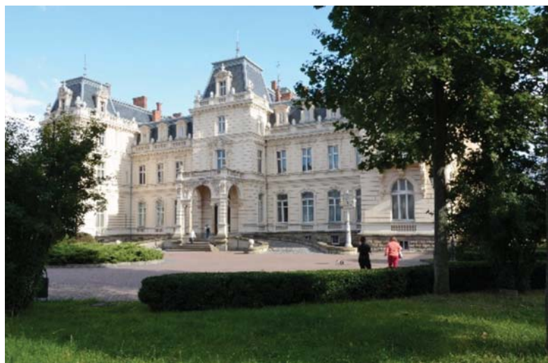
II. 12. Lwów. Pałac rodziny Potockich, zbudowany pod kierunkiem hrabiego Alfreda Potockiego. Eklektyzm w nurcie neorenesansowym. Obecnie rezydencja państwowa i galeria sztuki (fot. J. Partyka).
