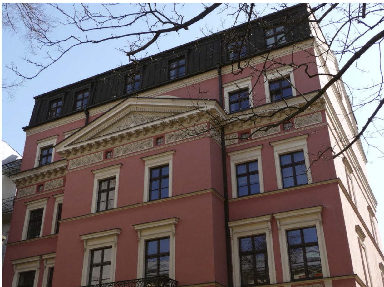
II. 2. Obecnie tzw. „Pałacyk Pod Orłem” z XVIII wieku. W 2004 roku nadbudowany o dwie kondygnacje stracił proporcje i swój charakter. Ulica Krupnicza w Krakowie (fot. B. Bartkowicz).
