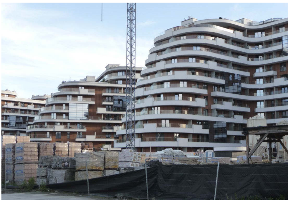
Il. 6. Kraków, śródmieście. Ogromne i nieestetyczne bryły obiektów mieszkalnych — „Wiślane Tarasy” — na terenie dawnych zakładów Zieleniewskiego w sąsiedztwie domu społecznego tych zakładów (potem kino Związkowiec, obecnie Teatr Varieté) w rejonie ulicy Grzegorzeckiej (fot. B. Bartkowicz).
