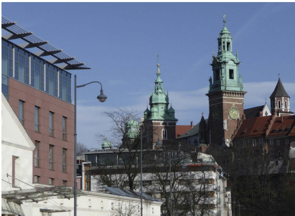
Il. 5. Przeskalowane i obce w formie bryły hoteli zbudowane w przedpolu widokowym Zamku Królewskiego na Wawelu od strony ulicy Powiśle i zakola Wisły (fot. B. Bartkowicz).
