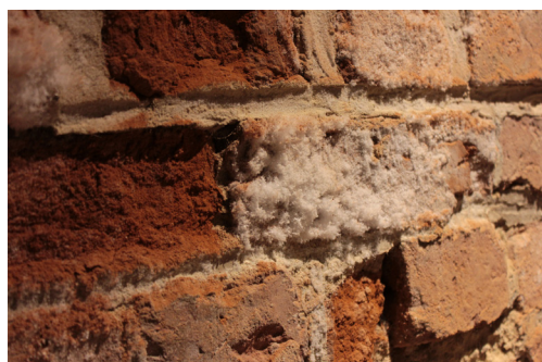
Il 2. Ściana w pomieszczeniu nr 13, widoczny poziom degradacji ceglanego muru. Fot. K. Wypych
