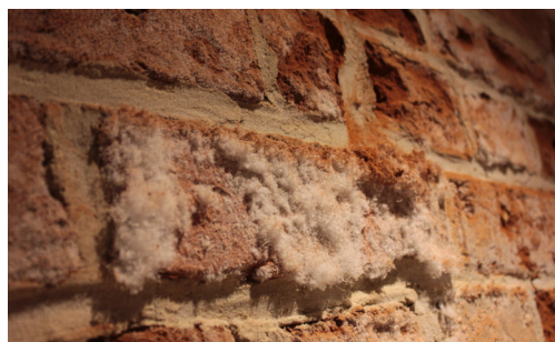
Il. 3–5. Krystalizujące sole i ich destrukcyjny wpływ na zabytkowe cegły w murach przyziemia zamku. Fot. K. Wypych
