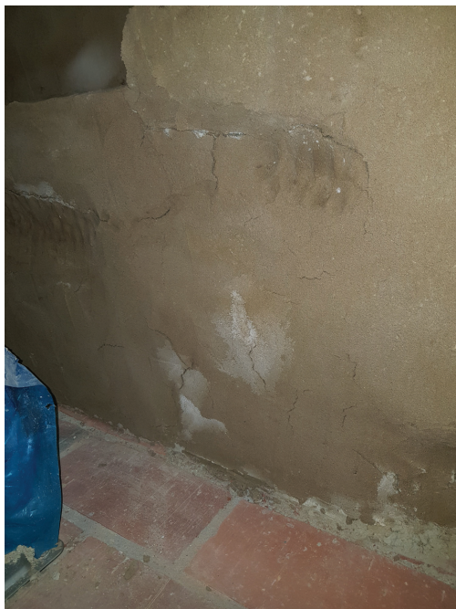
Il. 7, 8. Kompresy odsalające nałożone na ściany przyziemiu zamku; widoczne białe wykwity wyekstrahowanej z muru soli. Fot. K. Wypych
