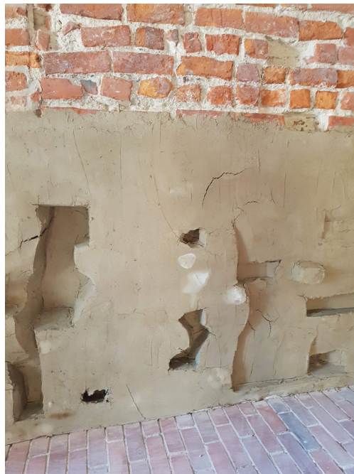
Il. 7, 8. Kompresy odsalające nałożone na ściany przyziemiu zamku; widoczne białe wykwity wyekstrahowanej z muru soli. Fot. K. Wypych
