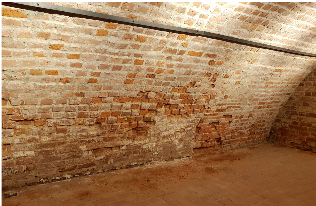
Il 2. Ściana w pomieszczeniu nr 13, widoczny poziom degradacji ceglanego muru. Fot. K. Wypych
