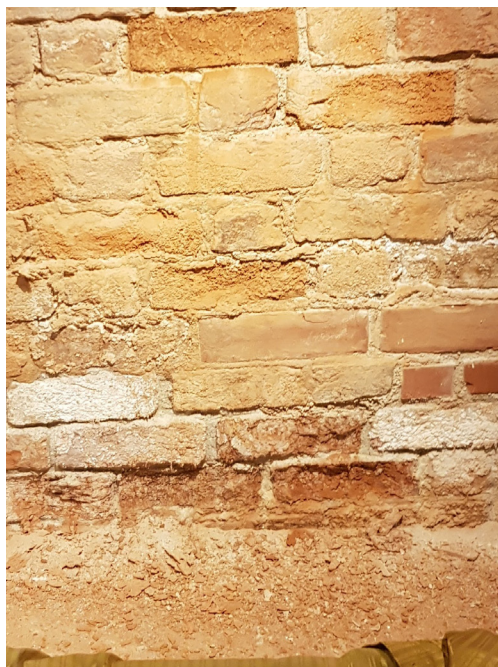
Il. 3–5. Krystalizujące sole i ich destrukcyjny wpływ na zabytkowe cegły w murach przyziemia zamku. Fot. K. Wypych
