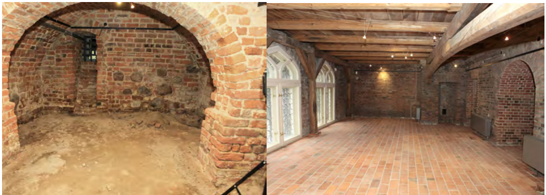
Il. 5. Remont przyziemi zamkowych, stan z 2012 i 2019 r. Fot. Z. Nowakowski
