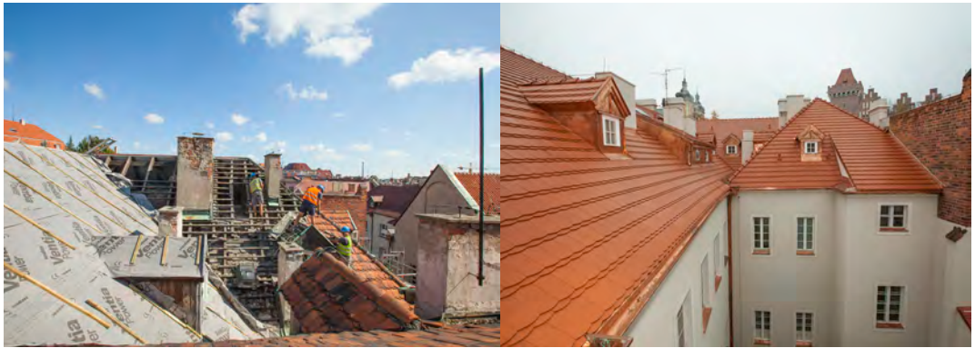
Il. 11. Remont dachu w Pałacu Działyńskich, 2014 r. Fot. Z. Nowakowski
