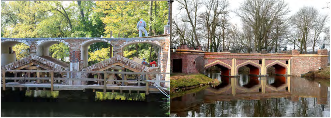
Il. 3. Remont mostu w latach 2009–2011. Fot. Z. Nowakowski
