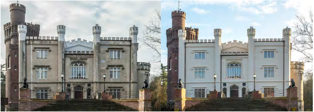
Il. 6. Renowacja elewacji Zamku w Kórniku, stan z 2011 i 2017 r. Fot. Z. Nowakowski
