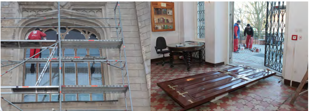
Il. 8. Rewaloryzacja i konserwacja stolarki w zamku kórnickim, 2012 r. Fot. Z. Nowakowski
