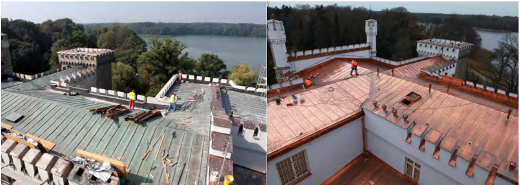
Il. 4. Remont dachu Zamku w Kórniku, 2011 r. Fot. Z. Nowakowski
