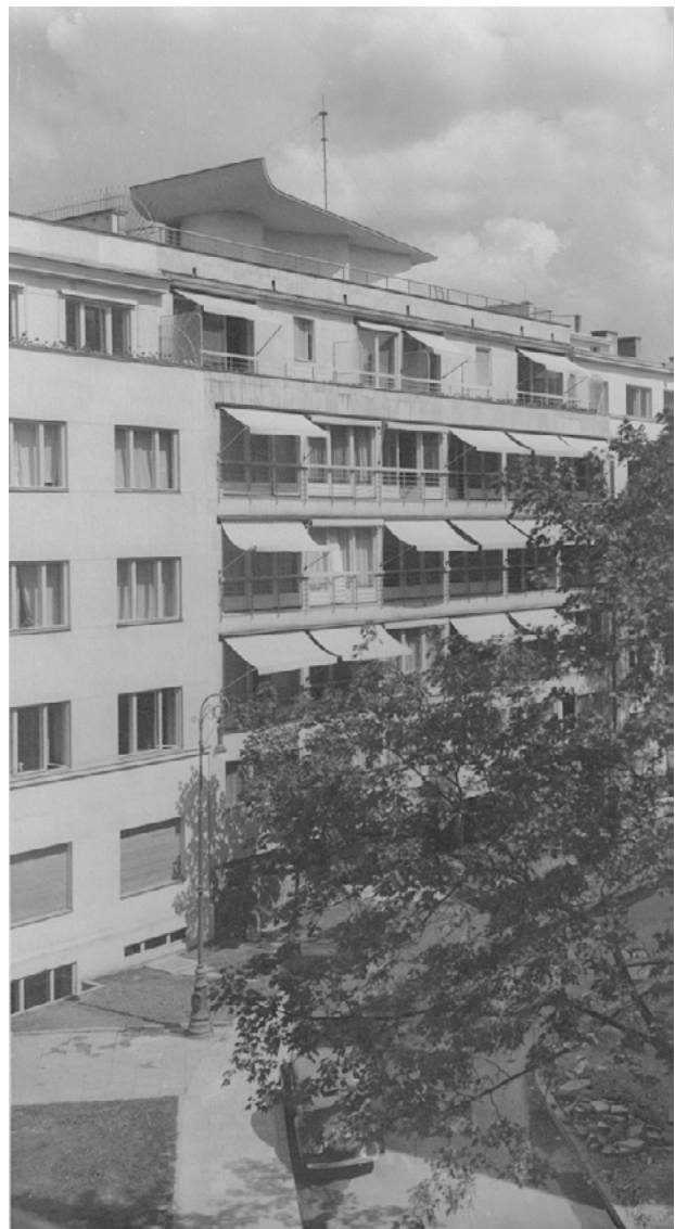
Il. 1. Dom mieszkalny, Warszawa, al. Przyjaciół 3, proj. Juliusz Żórawski, 1935–1937. Fot. Czesław Olszewski 1938
