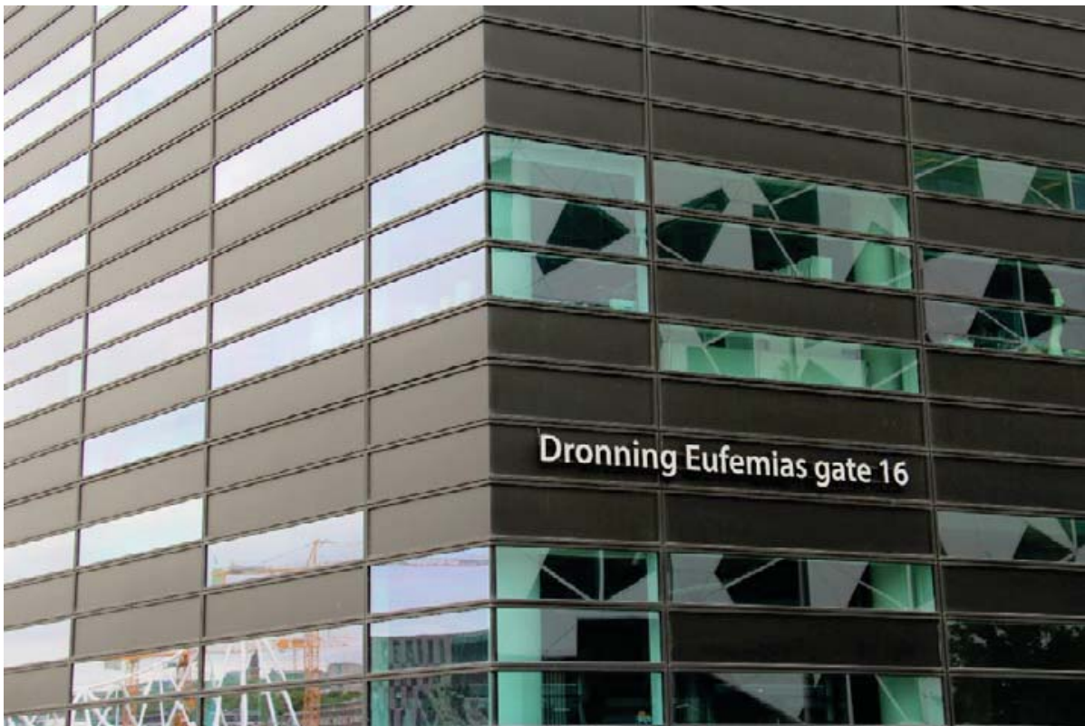
Il. 13. Detal elewacji biurowca Visma . Elewacja budynku została wykonana jako tzw. „fasada pikselowa” o nieregularnym układzie okien (fot. Maciej Złowodzki, 2017)
