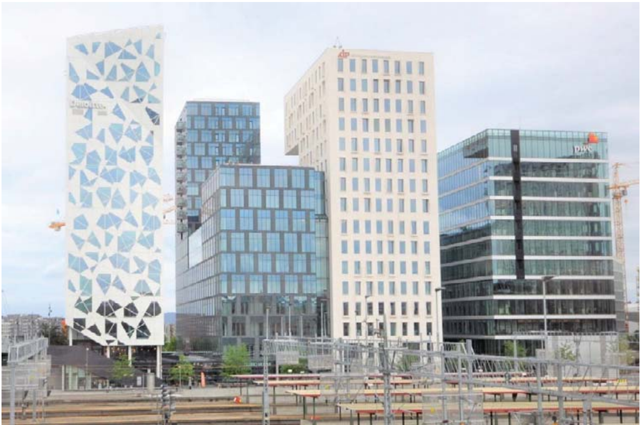
II. 8. Siedziba Kommunal Landspensjonskasse . Budynek to układ dwóch brył kontrastowych wizualnie, połączonych przeziwką (biurowiec w środku kadru) (fot. Katarzyna Zawada-Pęgiel, 2017)
