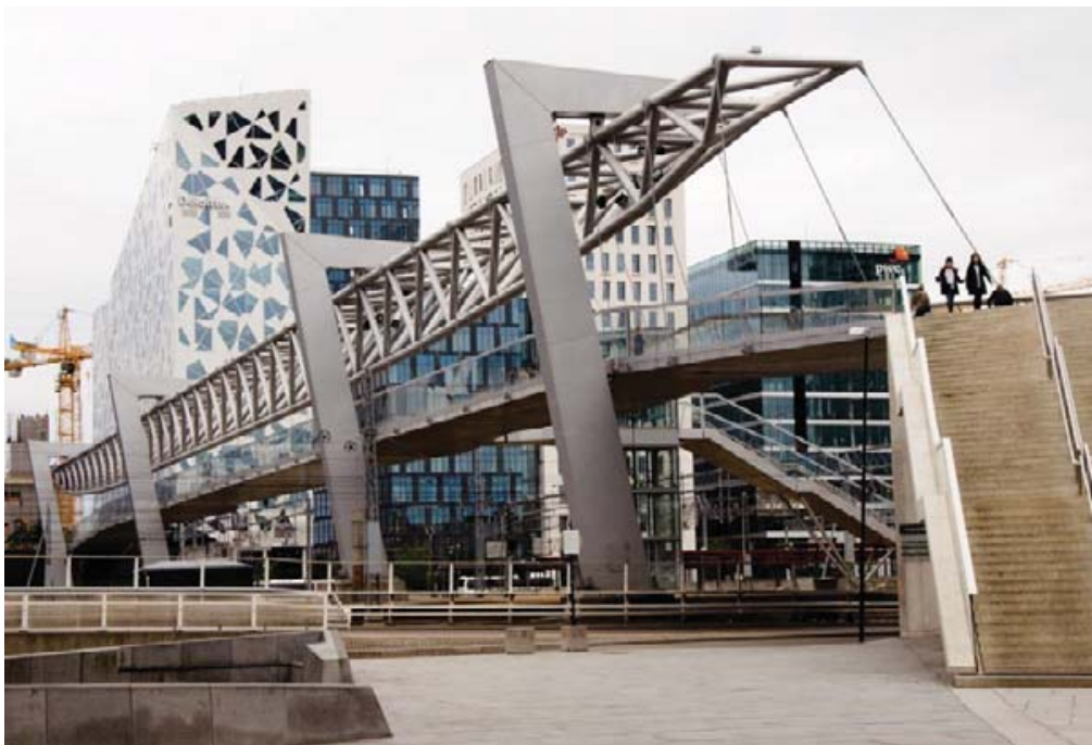
Il. 4. Widok na kładkę Akrobaten przerzuconą ponad torami głównego Dworca Głównego w Oslo, łącząca dwie dzielnice Gronland i Bjorvika (fot. Katarzyna Zawada-Pęgiel)
