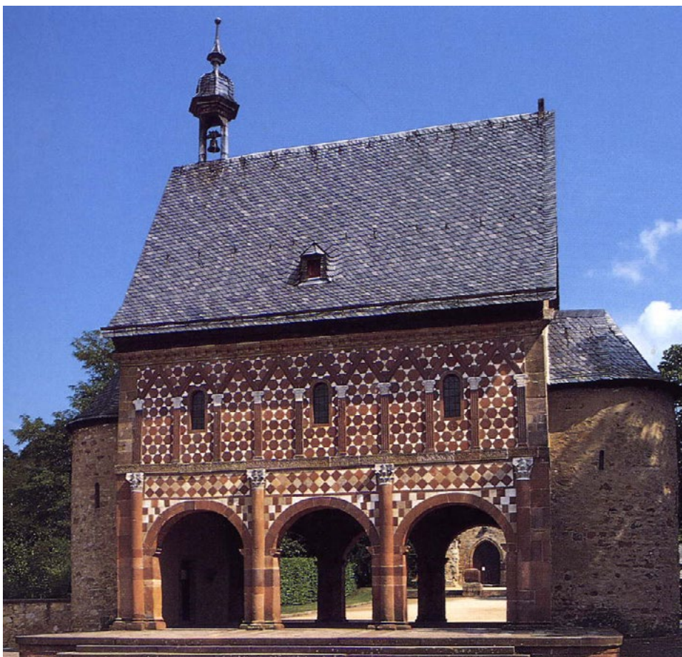
Il. 4. Portyk w Lorsch, fasada zachodnia. źródło: Barral I Altet X., Wczesne średniowiecze. Od późnego okresu antycznego do roku tysięcznego , Warszawa 1998
