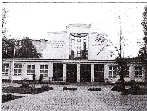
Fot. 1. Siedziba WSZiNS w budynku dawnej kotłowni (później mieścił się tam zakład produkcyjny), Tychy
