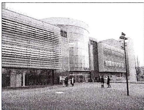
Fot. 7. Budynek Wydziału Prawa i Administracji, elewacje frontowa, Katowice
