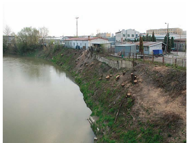
Fot. 4. Zabudowa usługowa przy odsłoniętej krawędzi koryta Wisłoka
