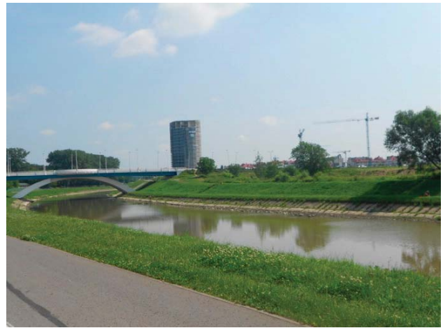
Fot. 2. Powstający kompleks Capital Towers w miejscu zabytkowej zabudowy
