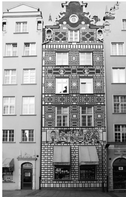
Fot. 4. Elewacja kamienicy przy Długim Targu 26
