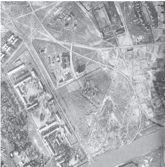
3. Faktyczny stan realizacji placu Grunwaldzkiego w 1935 r., fotoplan, Archiwum Państwowe m.st. Warszawy (za: T. Kotaszewicz, Międzywojenny okres planistyczny , [w:] Atlas historyczny Warszawy. Plany zagospodarowania przestrzennego z lat 1916–2002 , Warszawa 2004)
