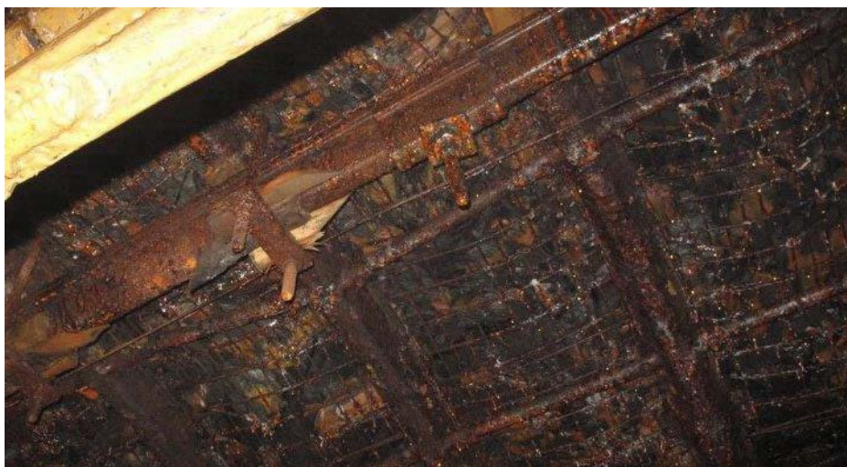
Rys. 2. Wzmacnianie obudowy łukowo podatnej przed frontem ściany z zastosowaniem długiej obudowy kotwowej strunowej o długości 6 m w chodniku podścianowym w kopalni podziemnej (fot. K. Skrzypkowski)
