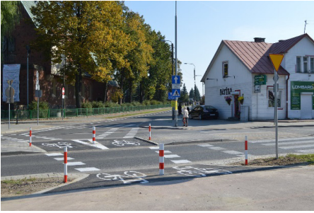
Fot. 1. Połączenie kontrapasu w ul. Wierzbickiej z drogą rowerową wzdłuż ul. Limanowskiego oraz z deptakiem na ul. Pawiej
