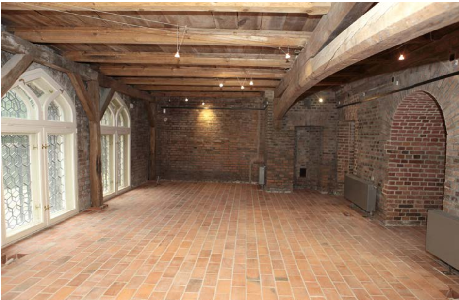
Przyziemia po renowacji. Fot. Z. Nowakowski
