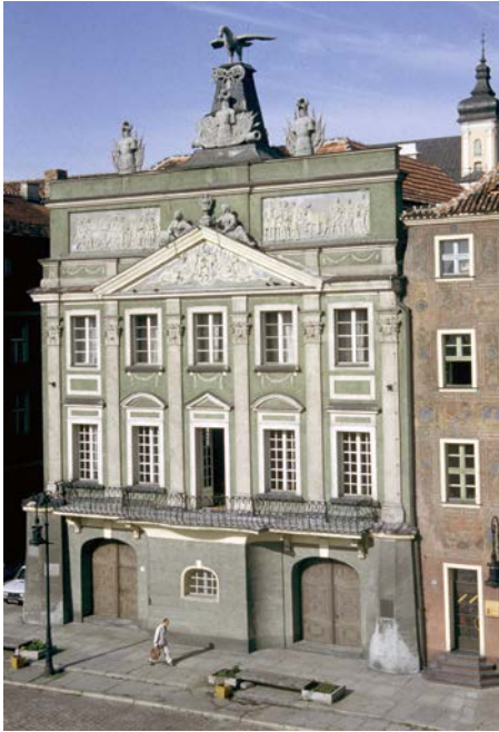
Pałac przed remontem elewacji. Fot. Z. Nowakowski
