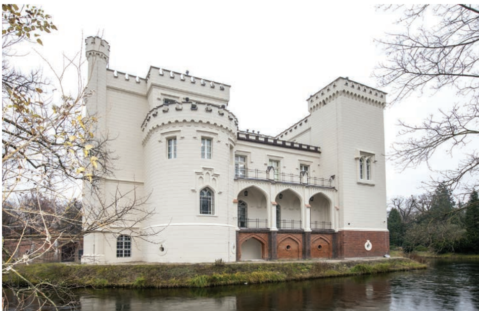
Elewacja zachodnia po remoncie, 2018. Fot. Z. Nowakowski
