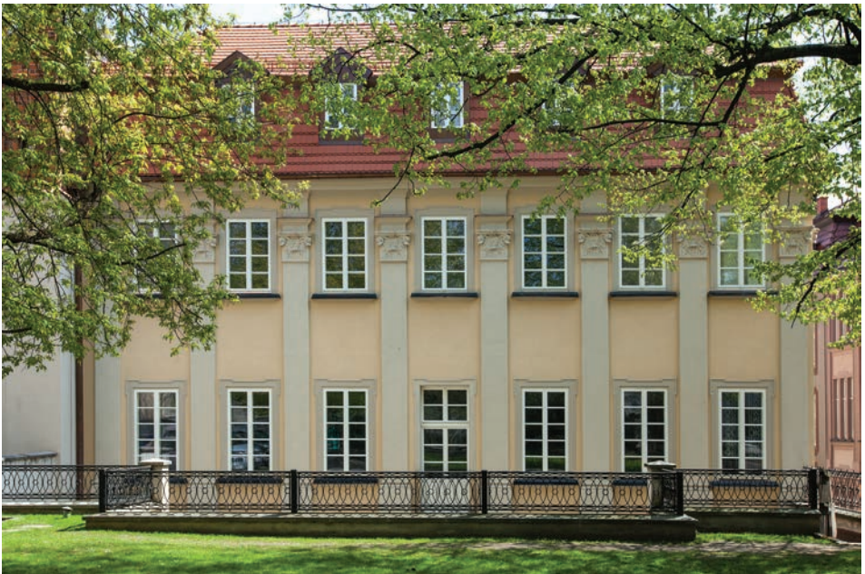
Elewacja ogrodowa po remoncie, po 2010. Fot. Z. Nowakowski
