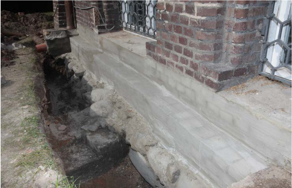
Renowacja przyziemi – izolacja zewnętrzna murów, 2012. Fot. Z. Nowakowski
