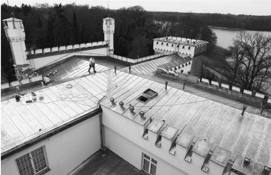
Dach Zamku Kórnickiego po remoncie. Fot. Z. Nowakowski
