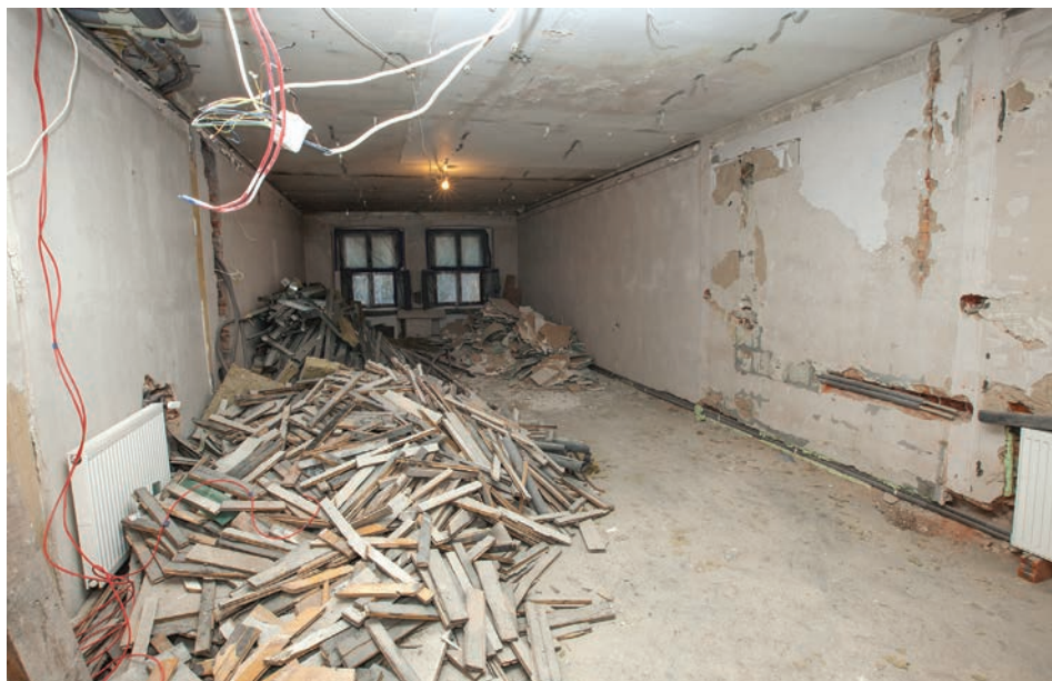
Pomieszczenia na II piętrze w trakcie remontu. Fot. Z. Nowakowski
