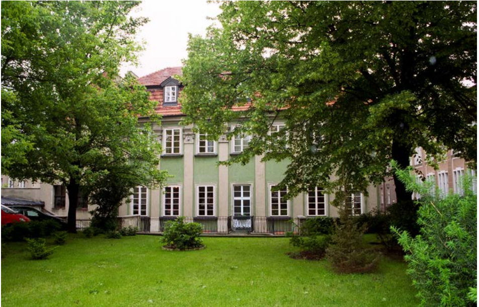
Elewacja ogrodowa przed remontem. Fot. Z. Nowakowski
