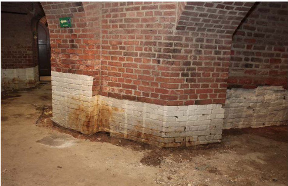
Renowacja przyziemi – odsalanie ścian, 2012. Fot. Z. Nowakowski
