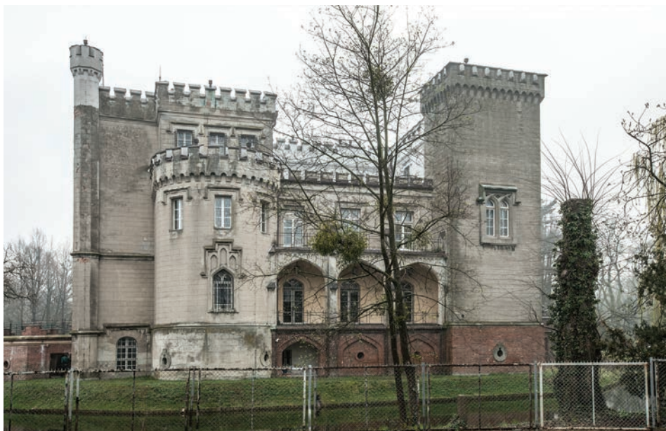
Elewacja zachodnia przed remontem. Fot. Z. Nowakowski
