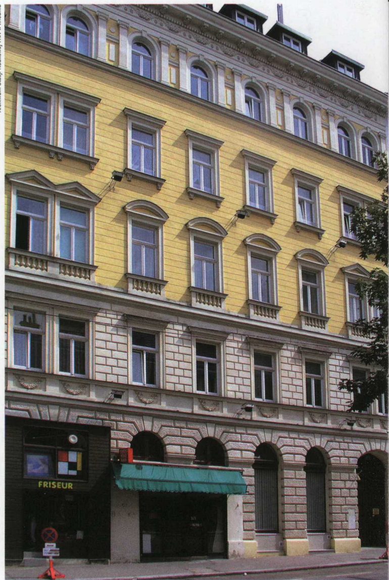
Fasada głównego gmachu siedziby Stacji Naukowej PAN w Wiedniu przy Boerhaavegasse 25, odremontowana w latach 90. XX wieku
