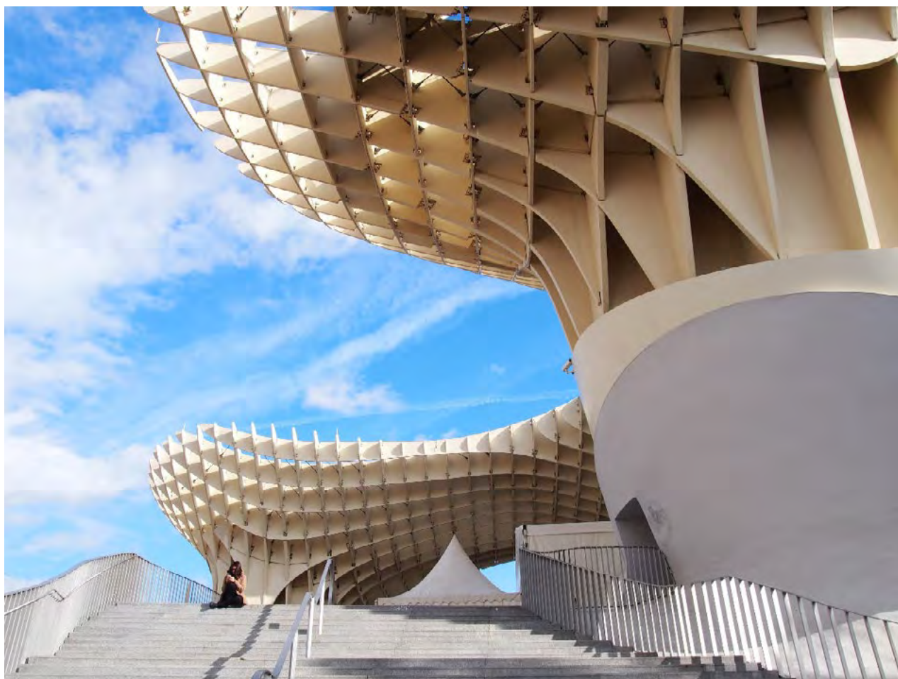
II. 1. Metropol Parasol, widok od strony północnej, 2018, fot.: J. Białkiewicz
