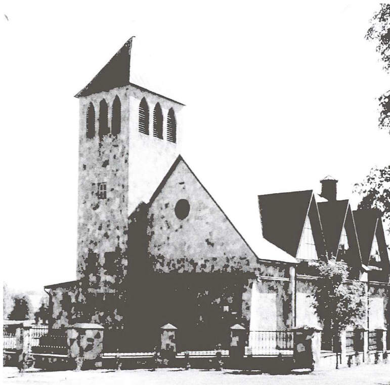
Fot. 7. Kościół w Mroczkowie Gościnnym z elewacją z piaskowców z miejscowego złoża
