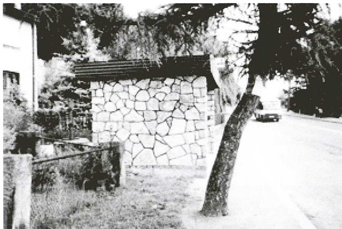
Fot. 5. Przystanek autobusowy w Skrzywnie, z ozdobną okładziną z miejscowego piaskowca
