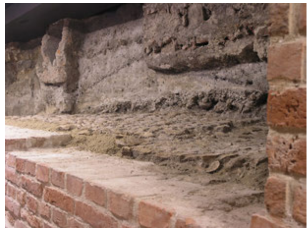
4.4. Kraków. Muzeum pod Rynkiem i Sukiennicami. Znaki czasu, relikwiczno średniowiecznego bruku pomiędzy ścianą ceglana u dołu a ścianą betonową u góry. Fot. aut.
