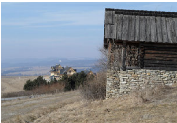
1a.5. Kluszkowce. Przeniesiona piwniczka (kamień) – lamus (drewno), w głębi nowy pensjonat. Fot. aut.
