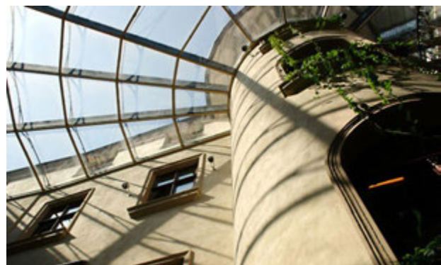
3.6. Kraków. Hotel Copernicus. Patio, oszklony dawny dziedziniec. Źródło: http://www.copernicus.hotel.com.pl za zgodą właściciela
