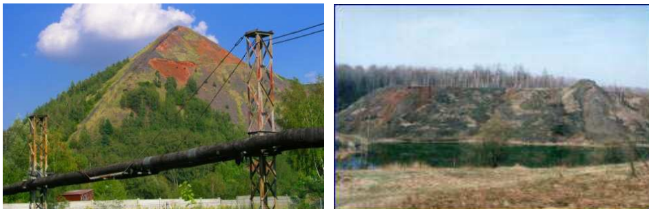
Fot. 3. Zwałowiska odpadów wydobywczych
