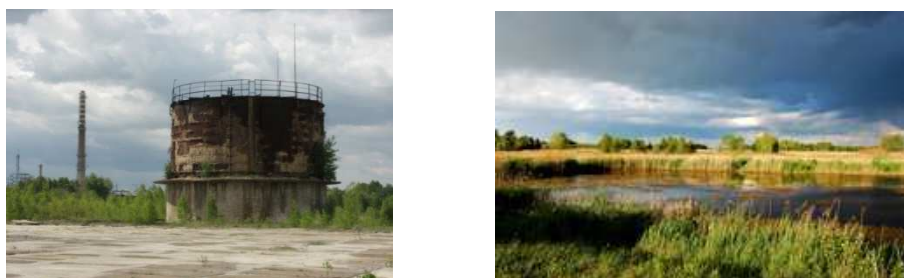
Fot. 5. Pozostałości po kopalni siarki w Grzybowie
